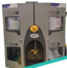
Si l'option d'une centrale de dilution a été prise, celle-ci doit être installée dans le local en zone «propres». De manipulation aisée et pratique, elle permet de doser un produit d'entretien de façon optimale et de réduire l'exposition chimique aux produits purs pour les utilisateurs.
