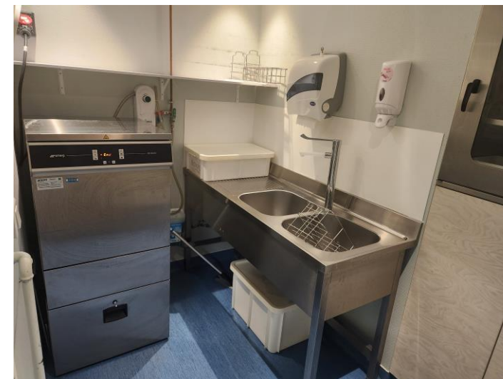
Salle de décontamination
